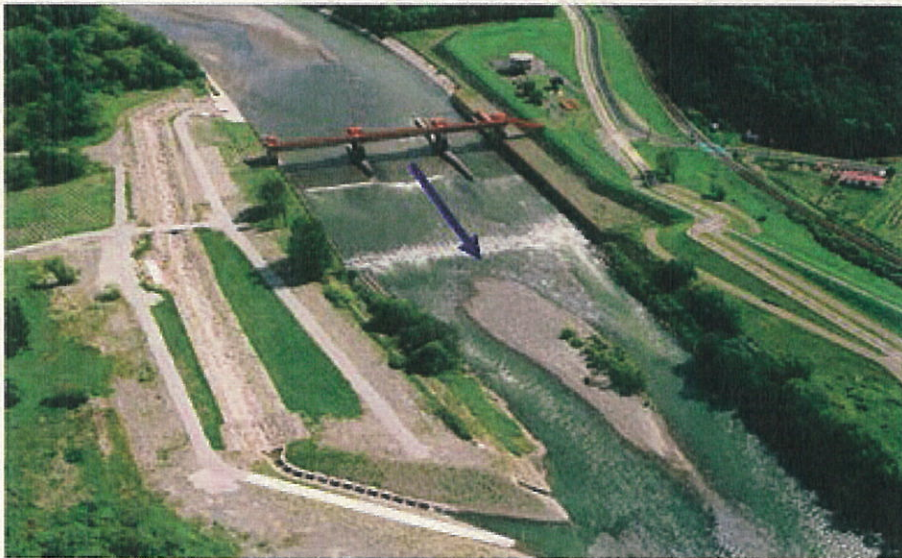
大雪頭首工魚道全景（下流より上流側を望む）
