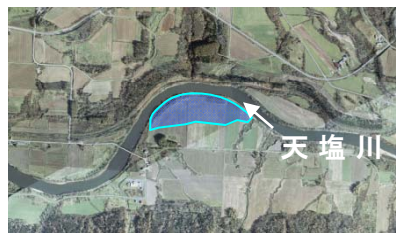
無堤区間の例 (KP100.4付近)
