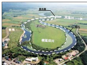
幌延旧川（上幌延1号新水路）
