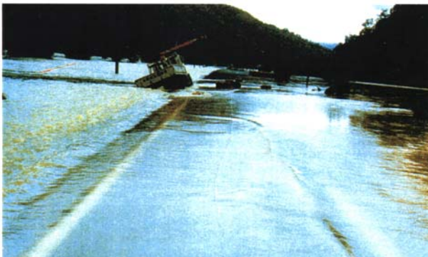
昭和 50 年 8 月洪水 （天塩川左岸 箴島左岸築堤の 溢水氾濫状況 音威子府村）
