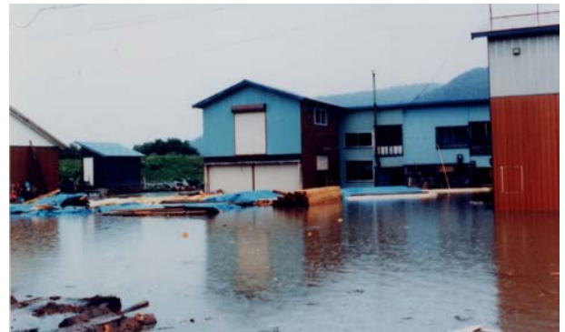
昭和 56 年 8 月洪水 (天塩川 音威子府市街の浸水状況)
