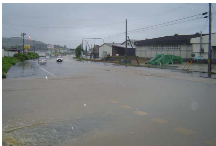
平成 22 年 7 月洪水 (国道 40 号線冠水状況(士別市街における 内水氾濫状況))
