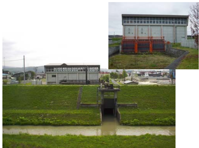
排水機場の例（天塩川 豊栄排水機場）
