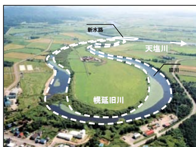
幌延旧川（上幌延 1 号新水路）
