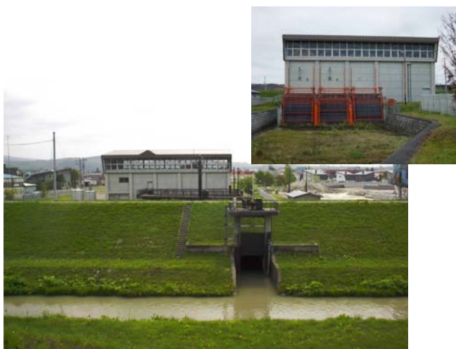
排水機場の例（天塩川 豊栄排水機場）
