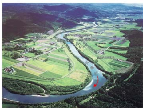
河道内樹木の状況 (天塩川KP110.2より上流・恩根内大橋付近)
