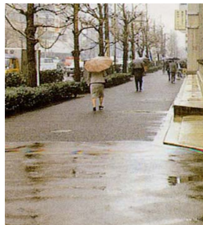
透水性舗装の整備事例
