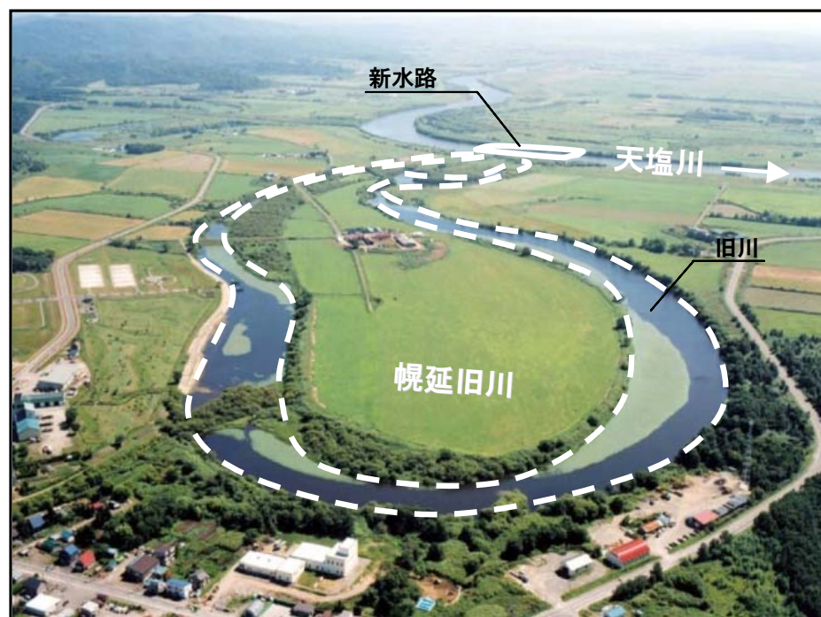
幌延旧川（上幌延1号新水路）
