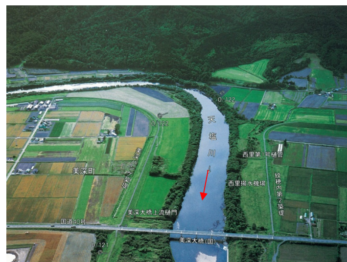
河道内樹木の状況 (天塩川KP121.0より上流・美深大橋付近)
