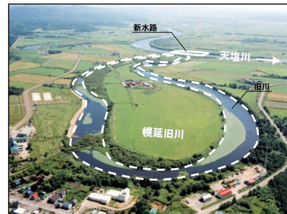
捷水路の例（上幌延1号新水路）
