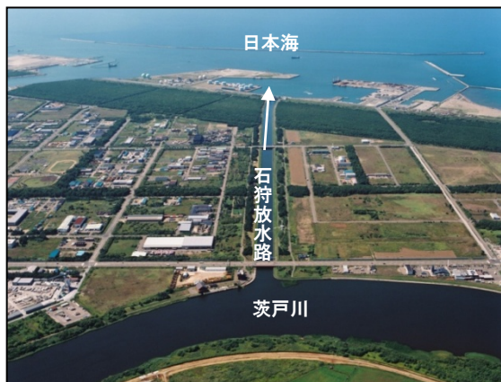
放水路の例（石狩放水路）
