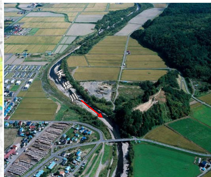
KP197付近の堤防未整備区間
