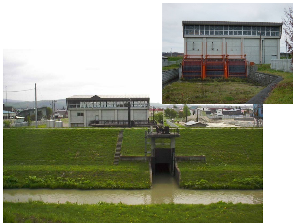
排水機場の例（天塩川 豊栄排水機場）
