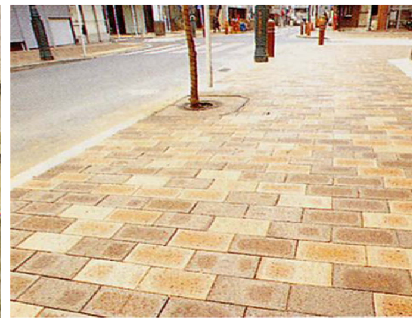
透水性ブロック舗装の整備事例
