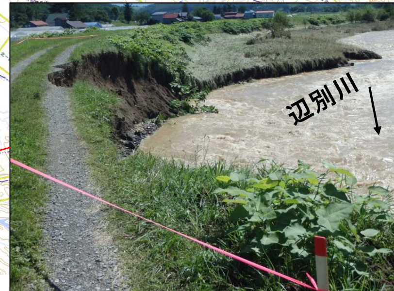
辺別川 右岸K7.2mk付近 河岸侵食・堤防一部流失状況
