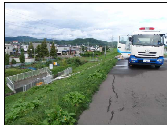
神居第3樋門 釜場（忠別川）排水ポンプ車稼動状況
