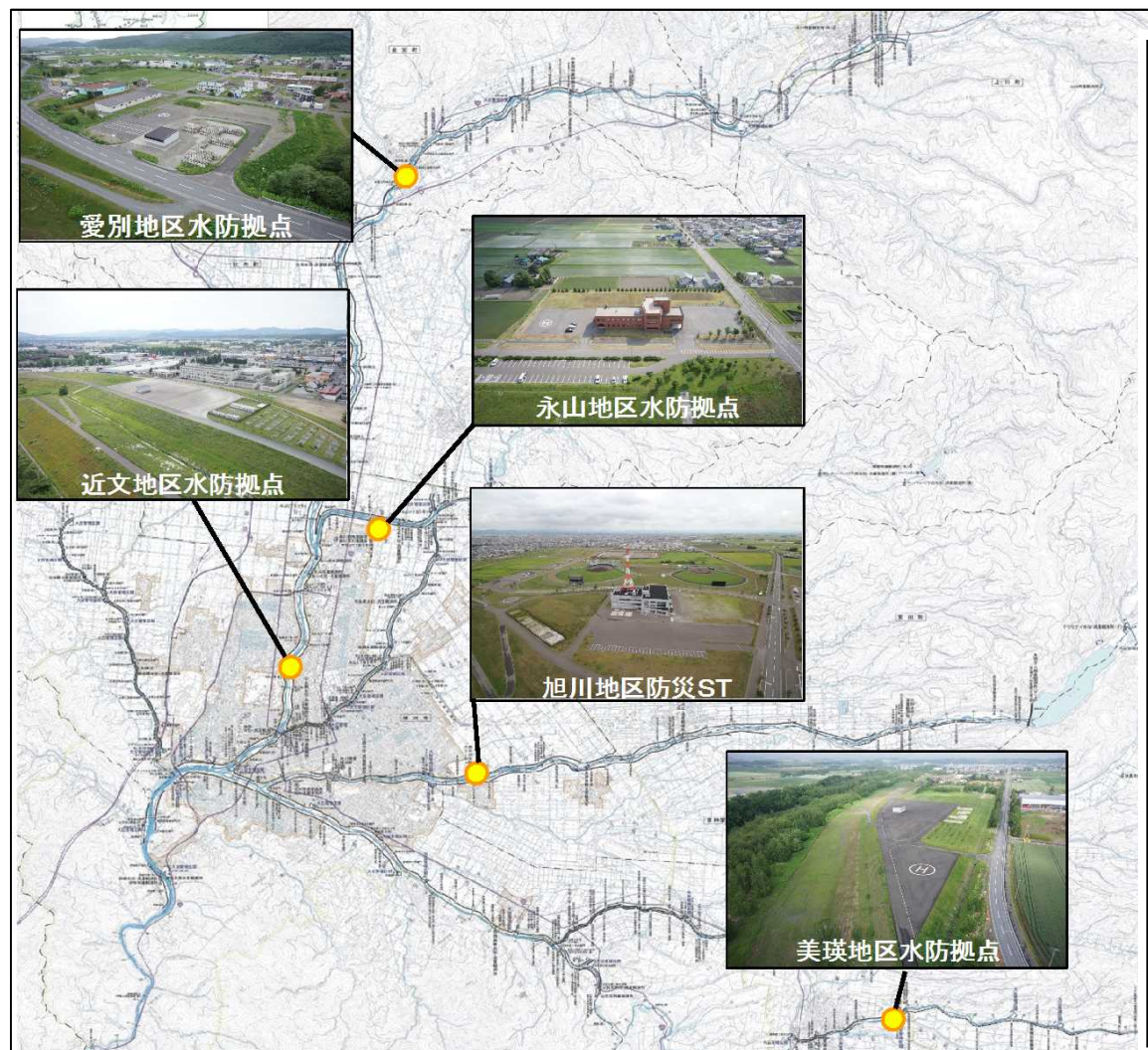
整備済水防拠点（石狩川上流）
