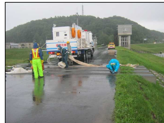
神居第4樋門 釜場（忠別川）排水ポンプ設置状況
