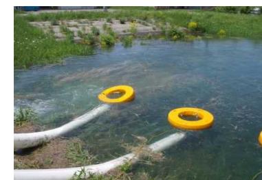
積込・運搬・作業状況
