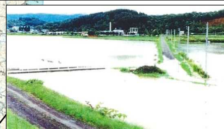
内水氾濫状況 (名寄市内淵地区)
