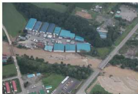
多量の土砂流入状況(ペケレベツ川)
