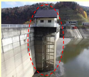
ダム取水施設の改修及び耐震化
