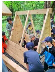
ツリーハウス組立作業状況
