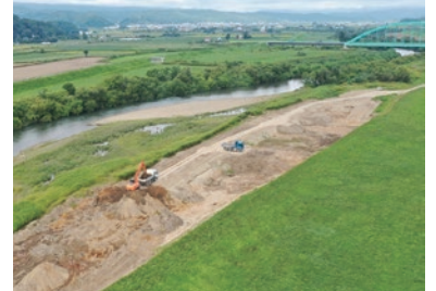
河道掘削状況
