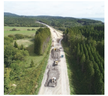
茂辺地木古内道路の整備状況
