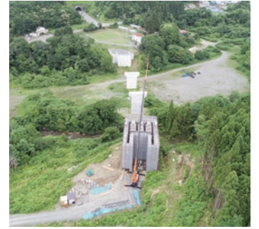
尾札部道路（大船大橋）の整備状況
