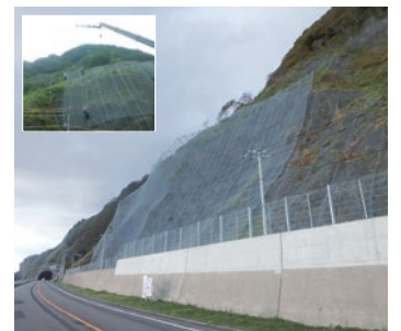
落石防護柵による法面対策整備状況
