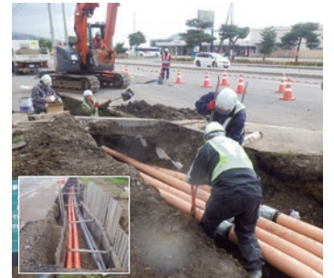
電線共同溝の管路設置状況
