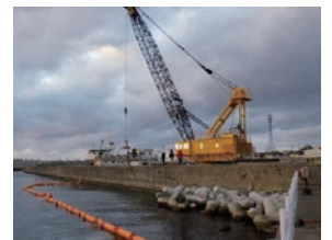
外郭施設整備状況(青苗漁港)
