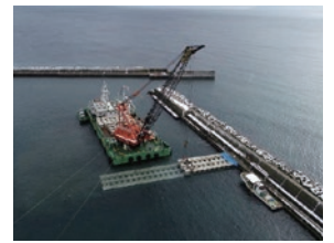
外郭施設整備状況(福島地区)
