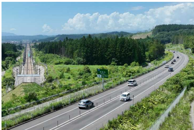
▲函館・江差自動車道 茂辺地木古内道路
