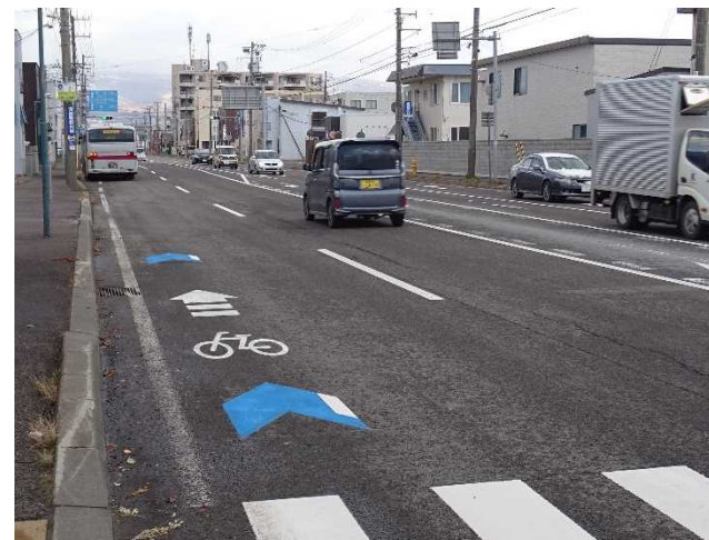
▲国道5号 自転車走行環境整備
