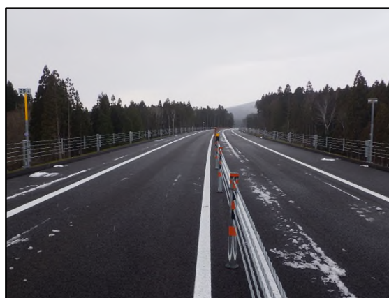
【ワイヤロープ設置】 (正面衝突事故対策)
