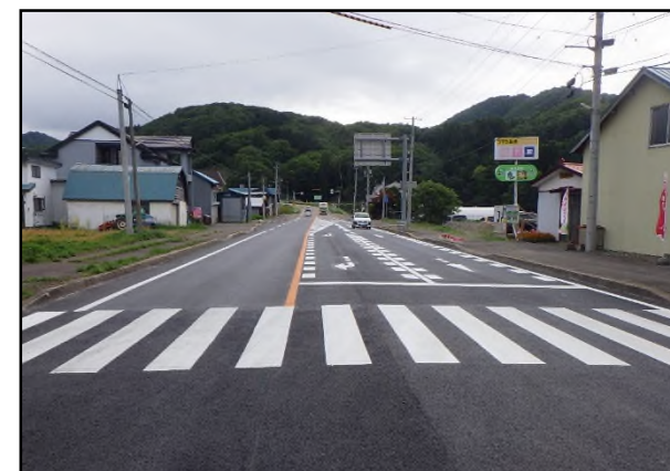
【右折車線設置】 (追突・右左折事故対策)
