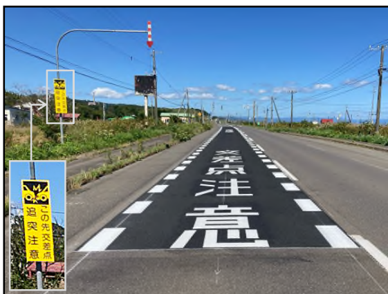
【滑り止め舗装・路面表示・法定外看板】 (追突事故対策)
