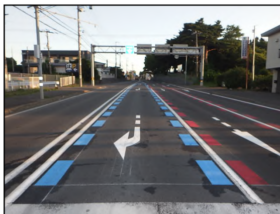
【滑り止め舗装・カラードットライン】 (追突事故対策)
