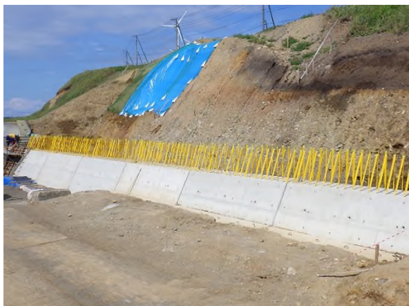
【防災対策(海岸擁壁)】
