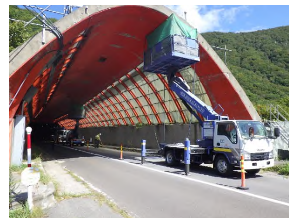
【トンネル補修】
