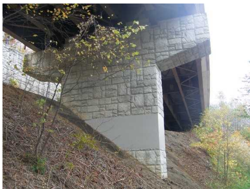
【耐震補強（下部工補強）】
