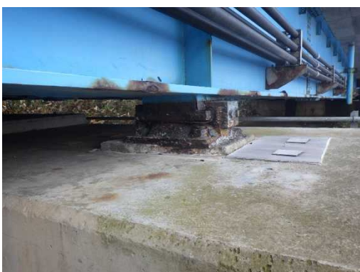
【橋梁補修前（支承）】
