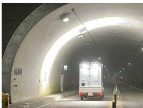
画像計測技術による覆工撮影
