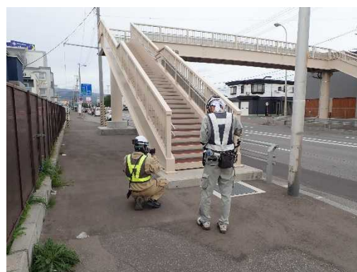
【横断歩道橋点検】
