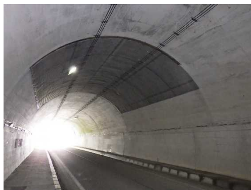
【道路トンネル補修】
