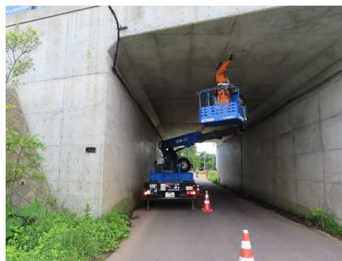
【大型カルバート点検】
