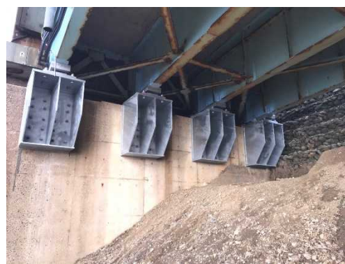
【耐震補強（落橋防止工）】
