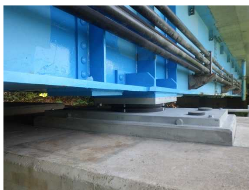
【橋梁補修後（支承）】
