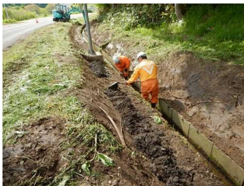
【排水構造物清掃】
