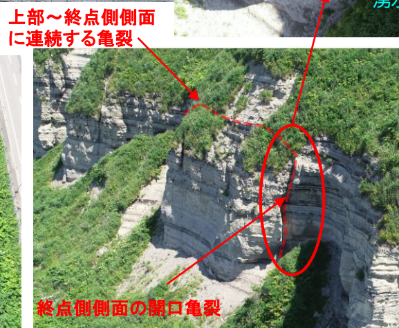
R3.6UAV撮影 終点側より
