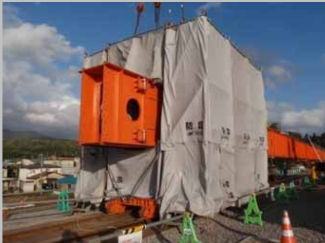
住居隣接地域での防音シートの設置
