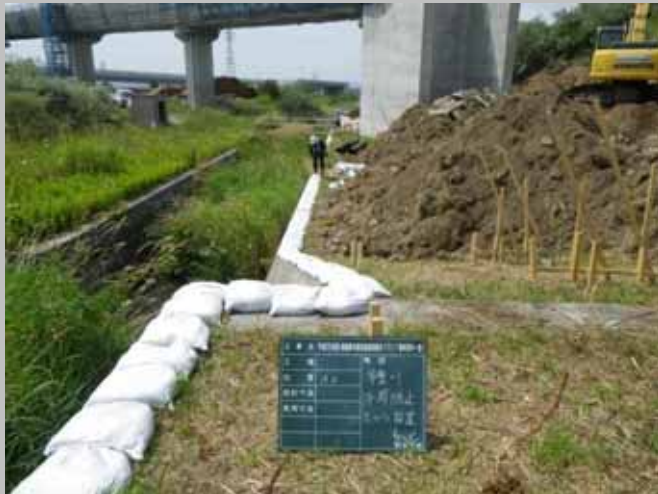
河川への濁水流出防止対策
