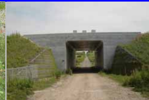
地中埋設型の形式において、侵入防止ネットにより侵入防止機能を持たせた構造形式を採用
