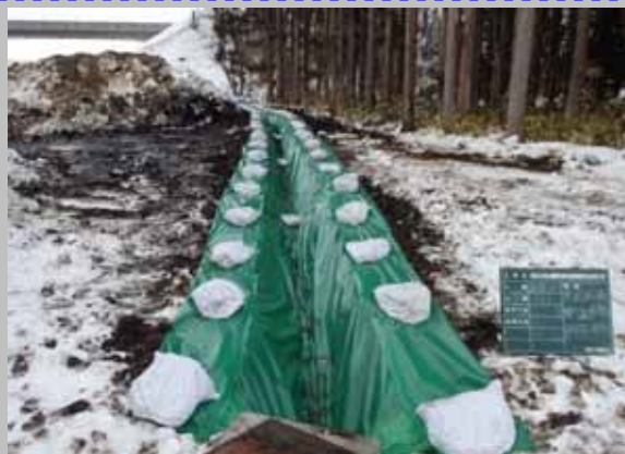
施工時の濁水流出により、河床材料や瀬淵構造の改変が生じないように、工所用仮排水流末箇所における沈砂池の設置
