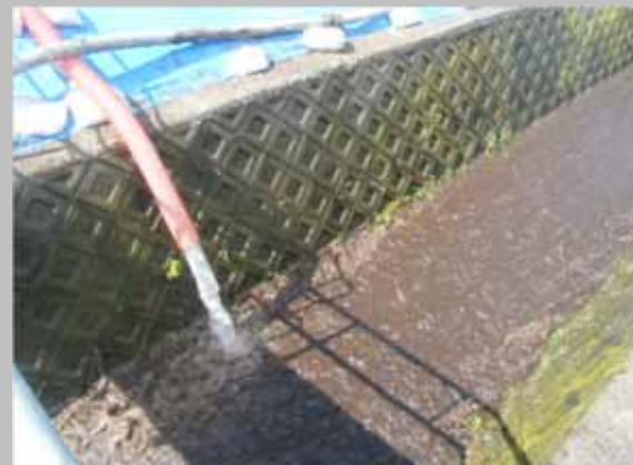
施工時の濁水流出により、河床材料や瀬淵構造の改変が生じないように、工所用仮排水流末箇所における濁水処理施設の設置
