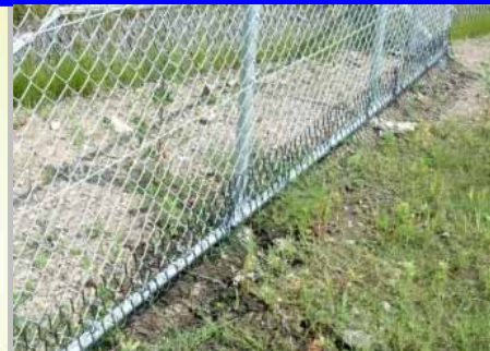
地中埋設型の形式において、侵入防止ネットにより侵入防止機能を持たせた構造形式を採用
