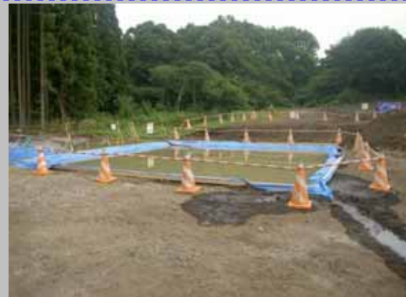
施工時の濁水流出により、河床材料や瀬淵構造の改変が生じないように、工所用仮排水流末箇所における沈砂池の設置
