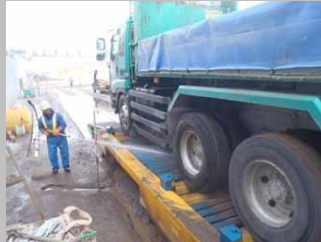
土砂等の一般道への散乱防止のためタイヤ洗浄
