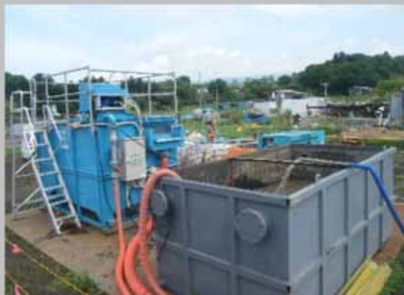
施工時の濁水流出により、河床材料や瀬淵構造の改変が生じないように、工所用仮排水流末箇所における濁水処理施設の設置
