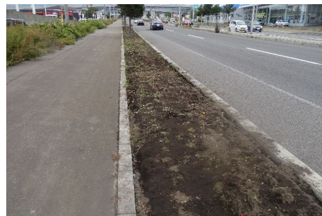
▲撤去後の植樹ます
