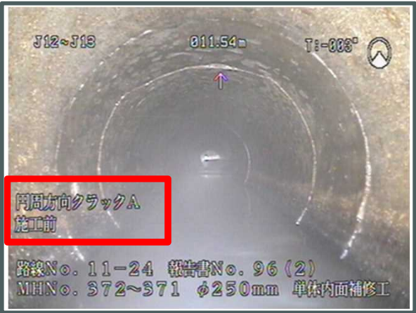
TVカメラによる管内の詳細調査
