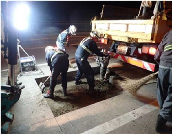
補修状況：国道12号（北海道札幌市）
