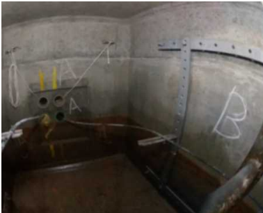
マンホール内写真
