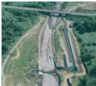
(チュウシベツ川取水施設～魚道上流部)
