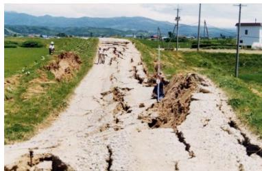
図 1-12 北海道南西沖地震による被害状況
