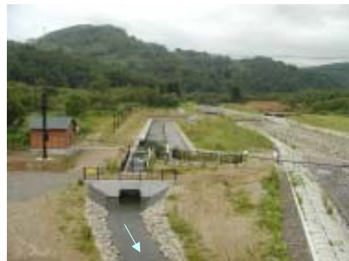
美利河ダム（魚道）
