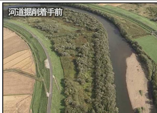
河道掘削着手前
