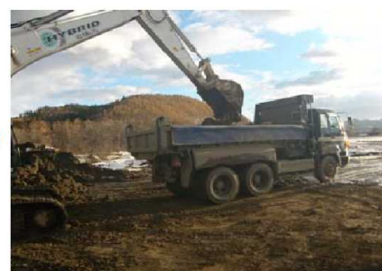
ダンプトラックへ積み込み、
