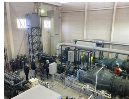
西兜野排水機場施設の更新・補強・補修(奥:2号P完了、中:1号P完了)
