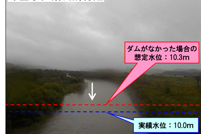
今金水位観測所付近
