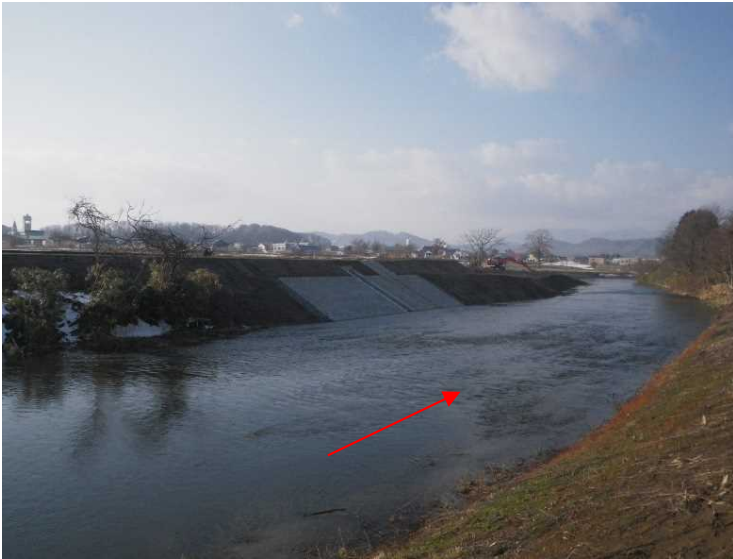
河道掘削・堤防整備等（真駒内川）
