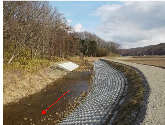
河道掘削・堤防整備等（トンケ川）
