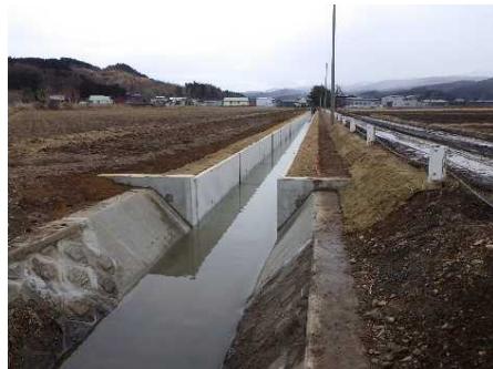
農業用排水路整備
