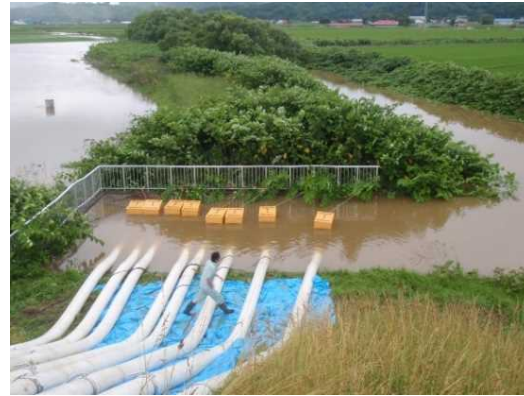
排水ユニットによる排水活動
