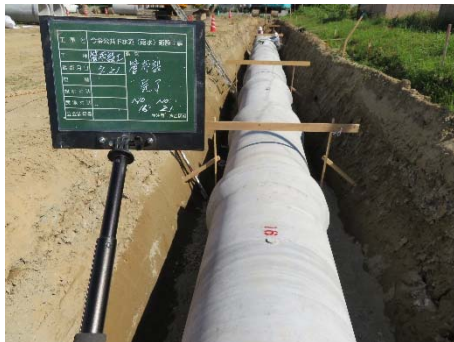
雨水管整備 Φ1000mm L=181.1m
