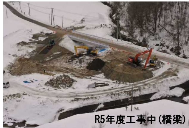
R5年度工事中（橋梁）
