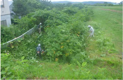
函館建設管理部実施前（接続水路）
