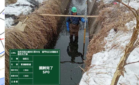
函館開発建設部実施後（堤内水路）
