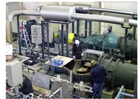
西兜野排水機場施設の更新・補強・補修(奥:2号P完了、中:1号P分解整備中)
