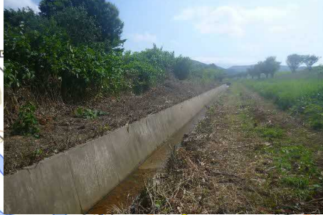
函館建設管理部実施後（接続水路）
