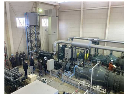
西兜野排水機場施設の更新・補強・補修(奥:2号P完了、中:1号P分解整備中)
