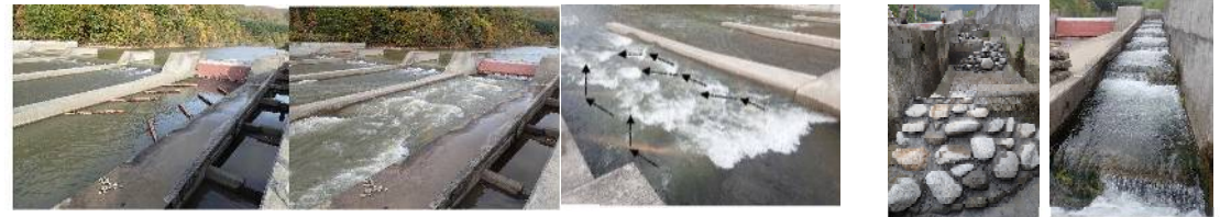
住吉頭首工流路の改善状況
