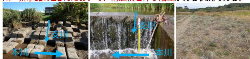
丸山川合流部の落差
