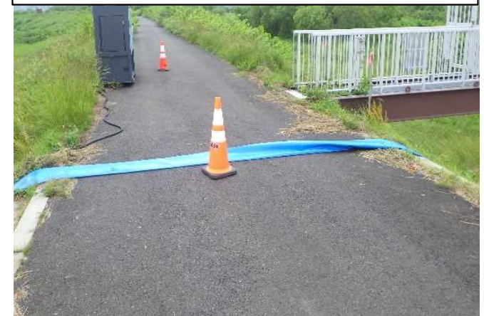
自治体) 農地内排水ポンプ設置状況(せたな町)
