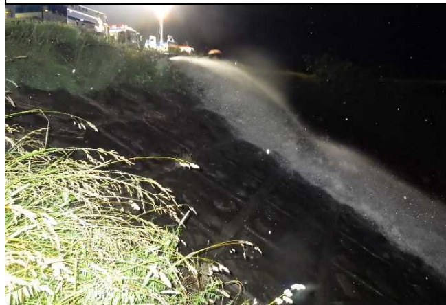
開建) 排水ポンプ車による支援 ②
