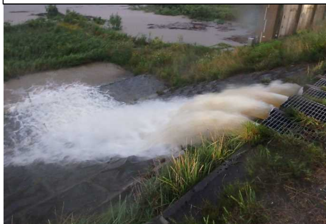
開建) 排水ポンプ車による支援 ②
