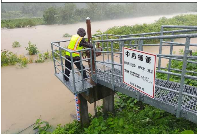
開建) 河川管理施設操作状況(樋門操作)
