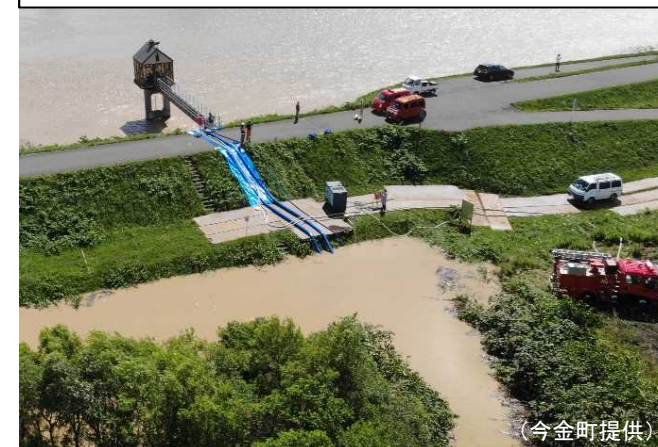
自治体) 市街地内水排除状況(今金町)
