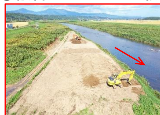
後志利別川流域の河道掘削 (函館開発建設部、函館建設管理部)
