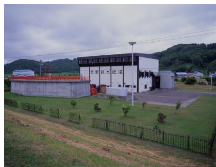
兜野排水機場 （昭和54完成）
