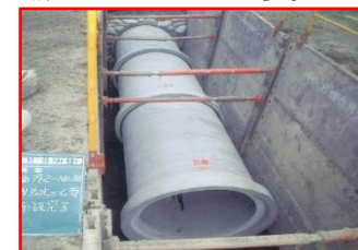
雨水下水道整備による流出抑制対策 (今金町・せたな町)
