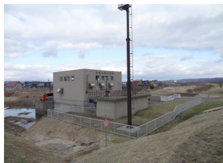
北桧山排水機場 （昭和59完成）
