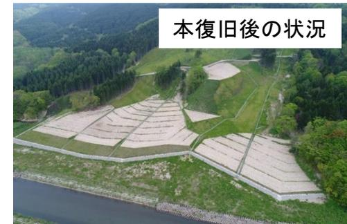
(参考)平成24年4月 地すべり性の斜面崩壊による河道閉塞の復旧状況
