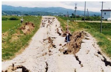
図 1-11 北海道南西沖地震による被害状況
