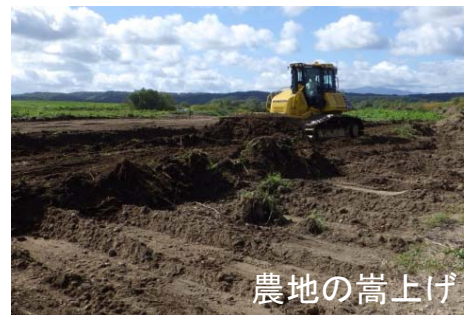
写真6-2 河道掘削土の活用 農地の嵩上げ
