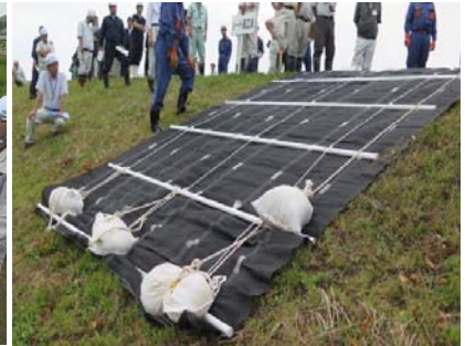
シート張り工
