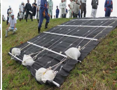
シート張り工
