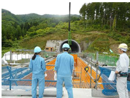
7月12日 函館道路事務所 （橋梁、トンネル現場）
