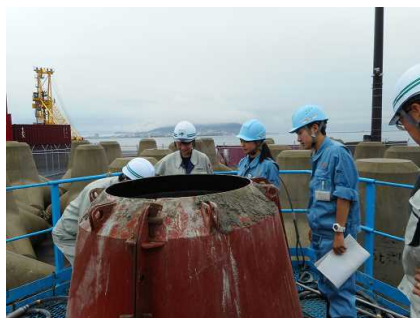
7月13日 函館港湾事務所 （消波ブロック製作現場）
