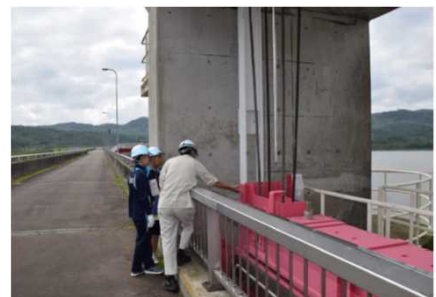
【ゲートの点検】
