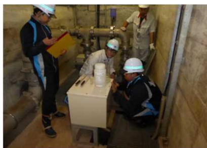
【監査廊の観測機器で点検】
