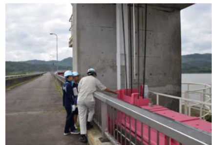
【ゲートの点検】
