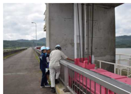
【ゲートの点検】
