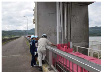
【ゲートの点検】
