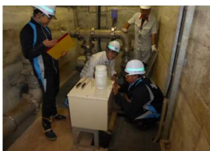
【監査廊の観測機器で点検】
