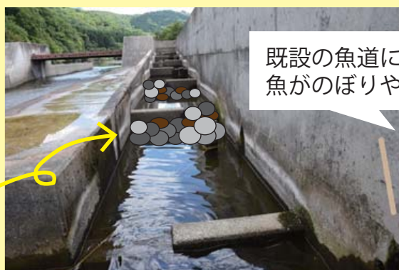
今回の魚道の改良区間
