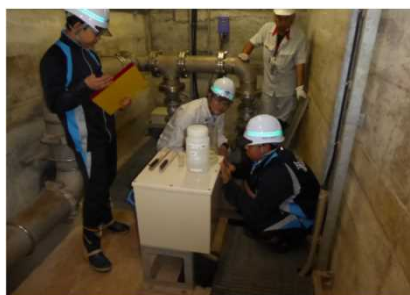
【監査廊の観測機器で点検】
