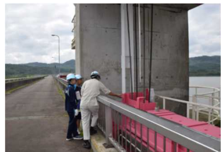
【ゲートの点検】
