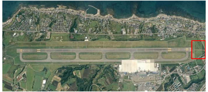
函館空港 滑走路端安全区域（RESA）整備箇所
