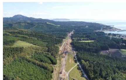
茂辺地木古内道路の整備状況
