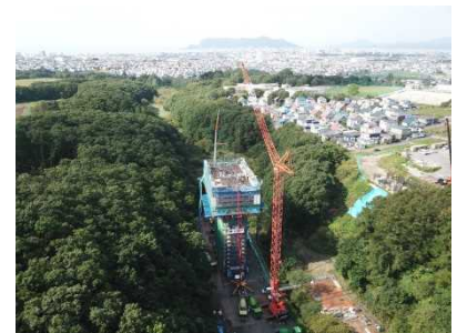
函館新外環状道路 空港道路の整備状況
