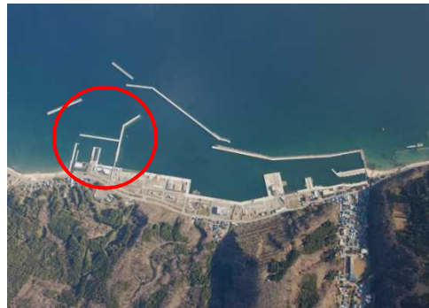
小型船だまりの整備が進む奥尻港
