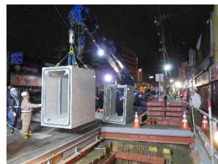
電線共同溝の整備状況
