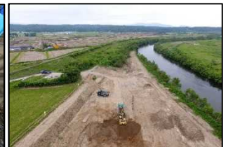
河道掘削状況
