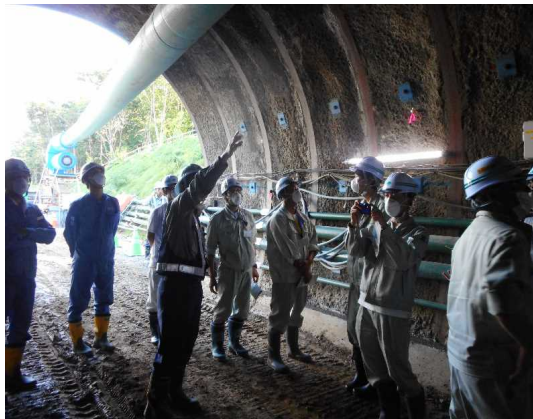
函館道路事務所（トンネル現場）
